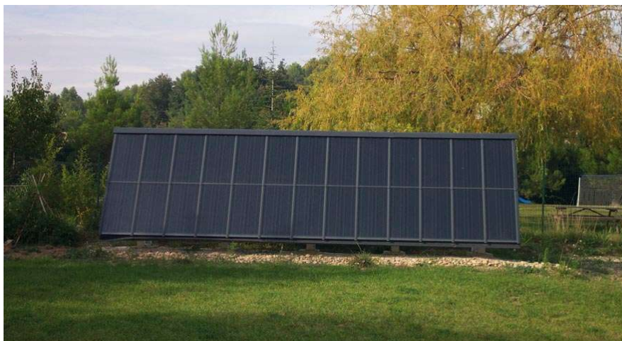
Capteurs solaires thermiques disposés dans le jardin. Pour chauffer l'eau chaude sanitaire et la maison.
