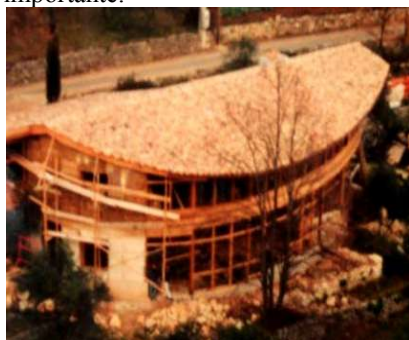
Maison lors de sa construction : on aperçoit l'ossature bois
