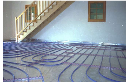
Pose du plancher chauffant
