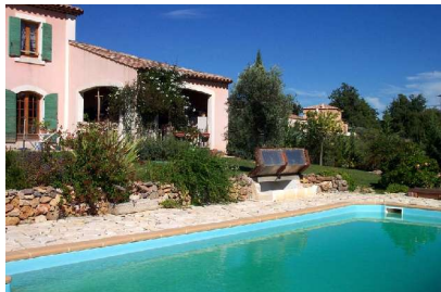
Maison et piscine chauffées par la PAC sur sol.
